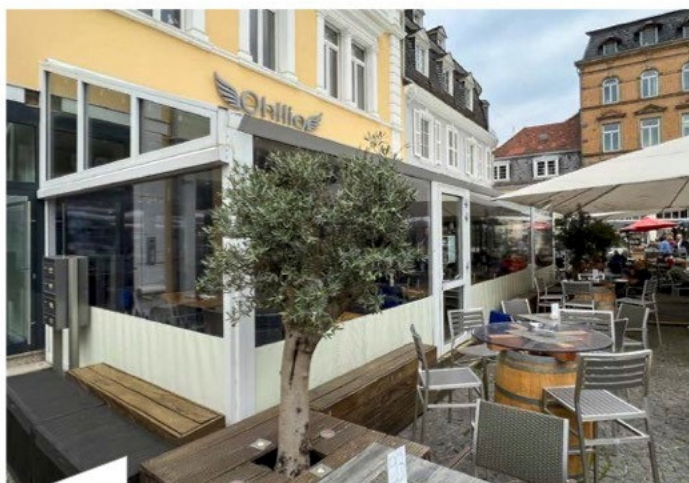
Die seitlichen Dreiecksfenster sind fest verglast, der untere Bereich kann dagegen bei schönem Wetter komplett geöffnet werden.
